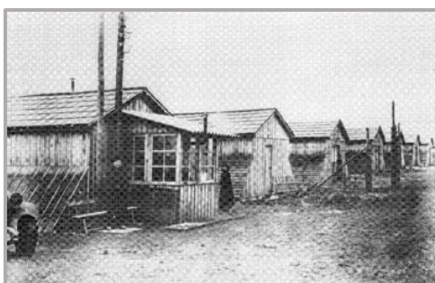
Baraques servant au logement des « nomades » dans le camp de la Route de Limoges à Poitiers (Vienne).
